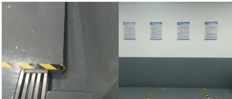
危废库内部照片
